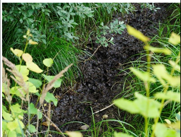
Bild 12: südl. Entwässerungsgraben trocken
